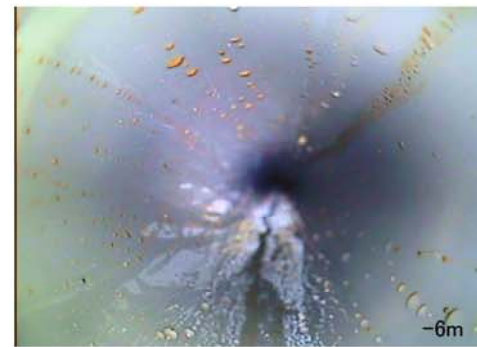
塩ビ管天端から-6m付近内部状況 (TP+17.49m付近) (GL-5.51m付近)
