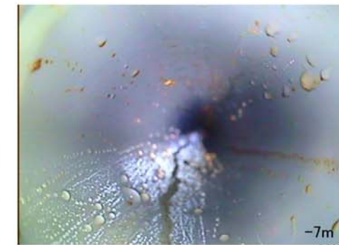
塩ビ管天端から-7m付近内部状況 (TP+16.49m付近) (GL-6.51m付近)
