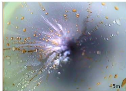
塩ビ管天端から-5m付近内部状況 (TP+18.49m付近) (GL-4.51m付近)
