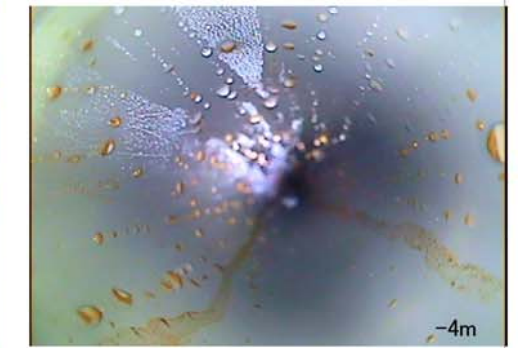
塩ビ管天端から-4m付近内部状況 (TP+19.49m付近) (GL-3.51m付近)
