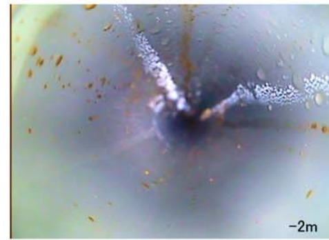
塩ビ管天端から-2m付近内部状況 (TP+21.49m付近) (GL-1.51m付近)
