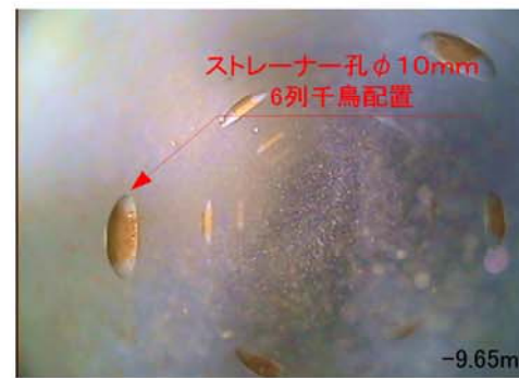
塩ビ管天端から-9.6m付近内部状況 (TP+13.84m付近) (GL-9.16m付近) (ストレーナー上端)
