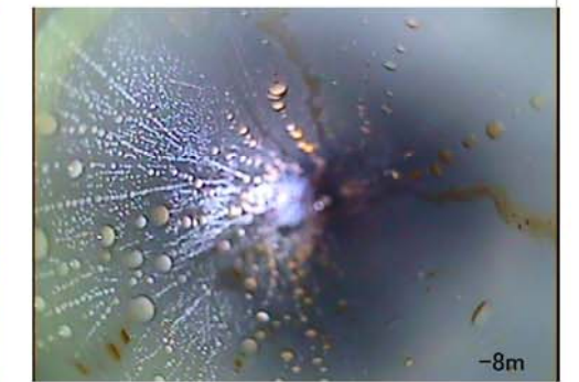
塩ビ管天端から-8m付近内部状況 (TP+15.49m付近) (GL-7.51m付近)
