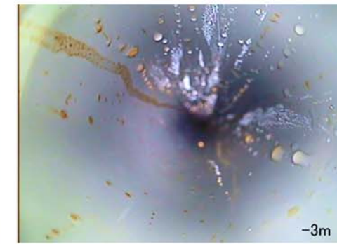
塩ビ管天端から-3m付近内部状況 (TP+20.49m付近) (GL-2.51m付近)
